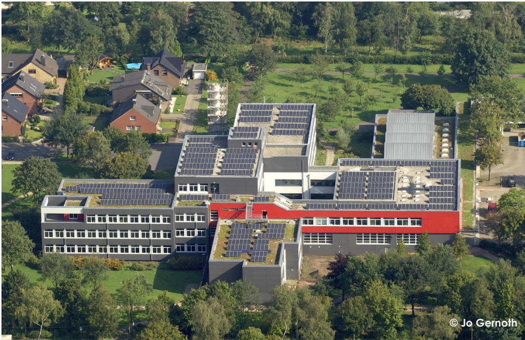
Abbildung 2-2: Photovoltaikanlage auf dem Schulzentrum Pliesterbeckerstraße (Dorstener Energiegenossenschaft)
