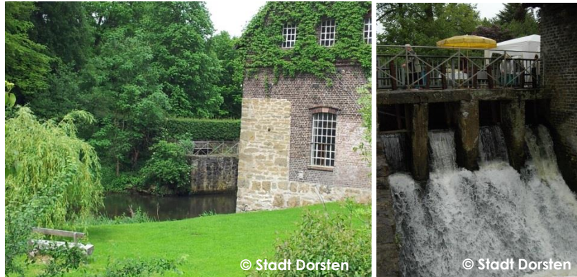
Abbildung 4-5: Tüshaus-Mühle (links) und Wehranlage Tüshaus-Mühle (rechts)
