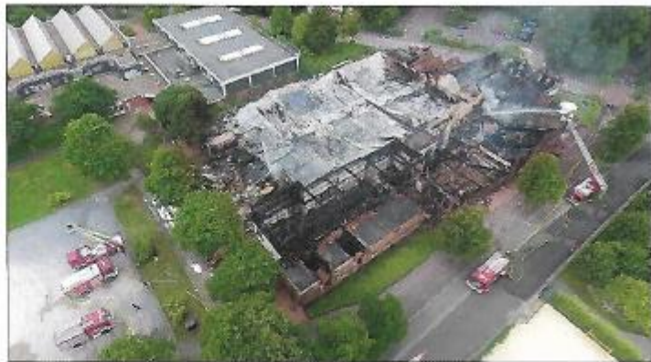
Am Tag danach: Der Gebäudekomplex ist völlig zerstört. Die Turnhalle des benachbarten Gymnasiums Petrinum konnte gehalten werden.
