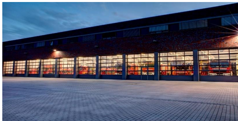
Fahrzeughalle der FuR bei Dämmerung
